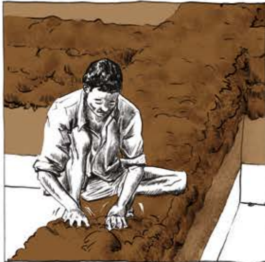
LES BOULES SONT EMPILÉES SUR LE SOUBASSEMENT PAR COUCHES D'ENVIRON 50 À 60 CM DE HAUTEUR. ELLES SONT SOUVENT DÉTÉES LES UNES SUR LES AUTRES POUR UNE MEILLEURE COHÉSION.
