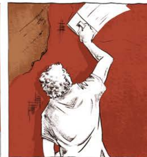
LE CORPS DE L'ENDUIT SERT À BOUCHER LES TROUS ET À HOMOGENÉISER LA SURFACE. CE MÉLANGE TRÈS SABLEUX ET/OU FIBREUX DE 2 À 3 CM D'ÉPAISSEUR EST APPLIQUÉ AVEC UNE TALOCHE OU UNE TRUELLE.
