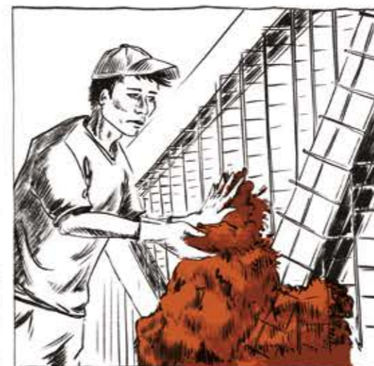
LE MÉLANGE EST PLAQUÉ À LA MAIN SUR LA STRUCTURE, ICI EN MAILLE D'ACIER.
