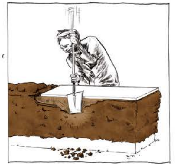
LES DEUX FACES DU MUR SONT TAILLÉES À L'AIDE D'UNE BÈCHE OU D'UN OUTIL TRANCANT.
