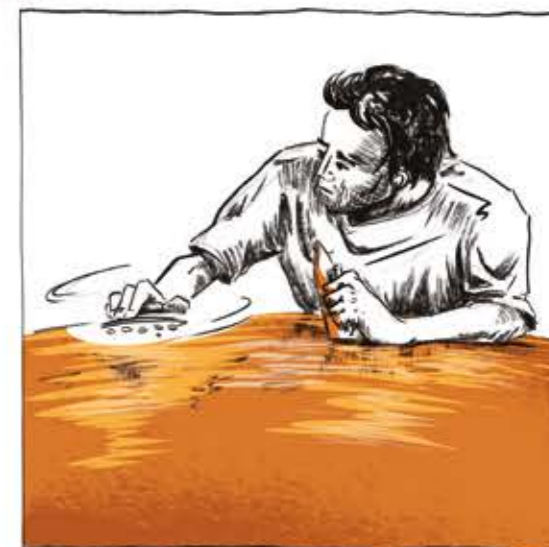
LA DERNIÈRE COUCHE EST TRÈS FINE. ICI, LE MÉLANGE D'ARGILE, SABLE FIN ET CIRE A ÉTÉ APPLIQUÉ À LA TRUELLE ET POLI POUR OBTENIR UNE FINITION BRILLANTE.
