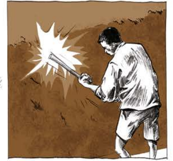
CHAQUE COUCHE EST BATTUE POUR REFERMER LES FISSURES ÉVENTUELLEMENT APPARUES LORS DU SÉCHAGE, QUI DURE ENVIRON DEUX SEMAINES.
