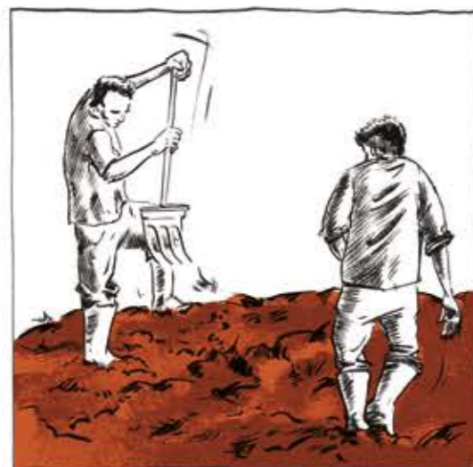
LA TERRE EST MALAXÉE AVEC DE L'EAU (15 À 30 %) POUR OBTENIR UN MÉLANGE HOMOGENÈME À L'ÉTAT PLASTIQUE, AMENDÉ ICI AVEC DE LA PAILLE.
