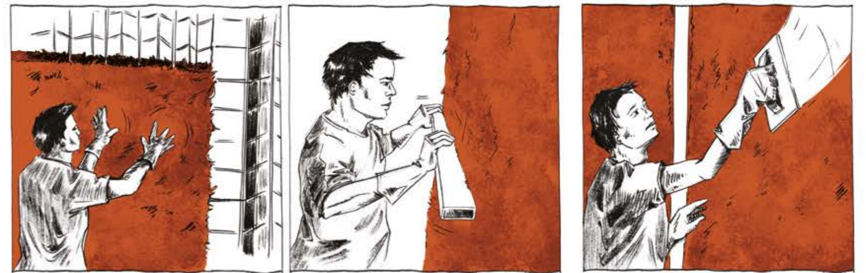
LA TERRE EST LISSÉE À LA MAIN.
