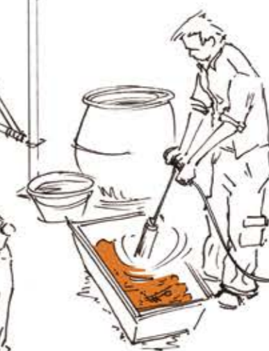
LA DERNIÈRE COUCHE EST TRÈS FINE. ICI, LE MÉLANGE D'ARGILE, SABLE FIN ET CIRE A ÉTÉ APPLIQUÉ À LA TRUELLE ET POLI POUR OBTENIR UNE FINITION BRILLANTE.
